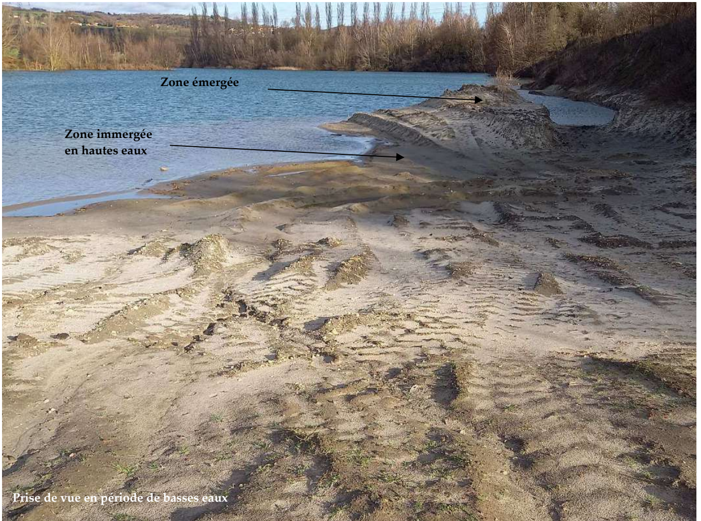
Photographie 11 : Aménagement soumis aux battements de nappe réalisé au droit de l'ancienne carrière
